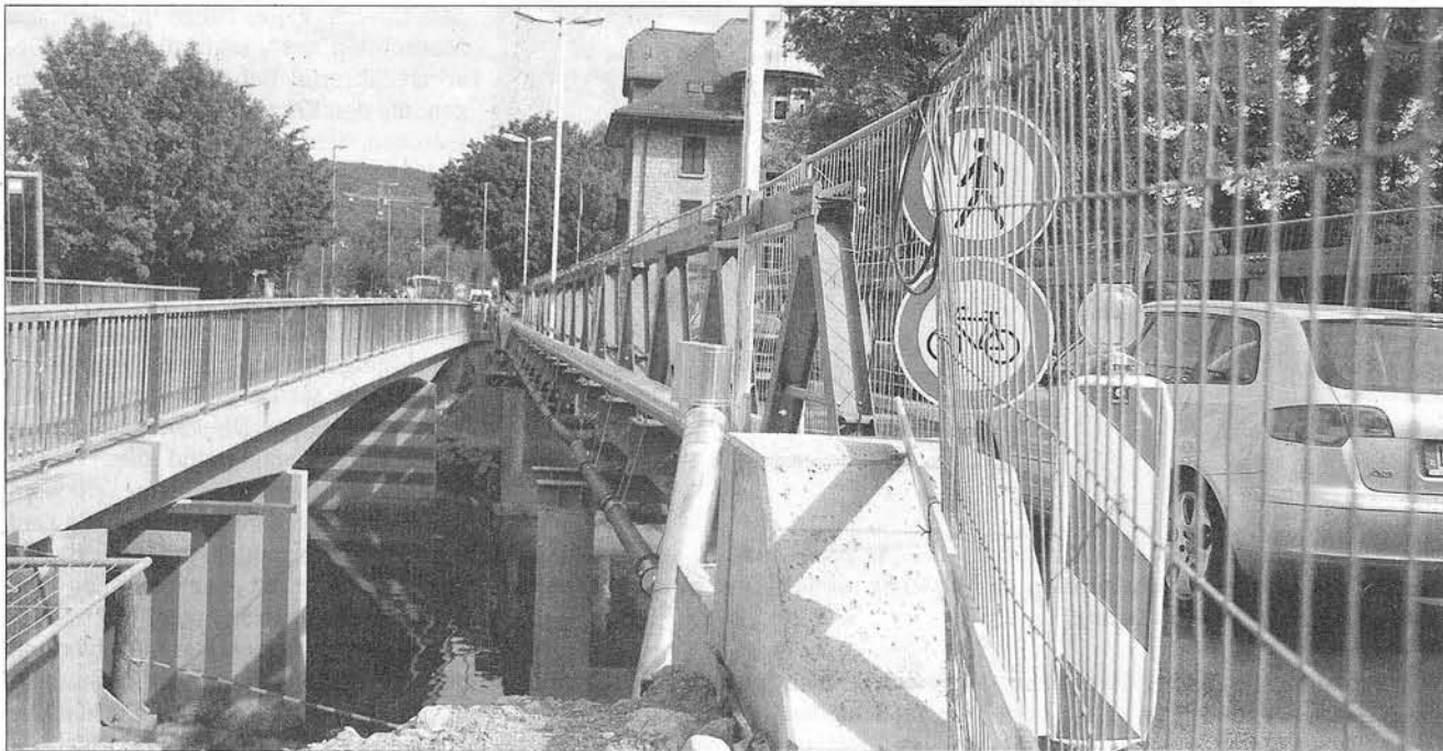
Solange das Fundament am rechten Ufer gesichert wird, dürfen nur Radfahrer und Fußgänger die Weilstraßenbrücke (links) überqueren. Der motorisierte Verkehr rollt über die Behelfsbrücke daneben. FOTO: DANIEL GRAMESPACHER
